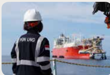
LNG regasification process in FSRU Lampung by PGN LNG.
